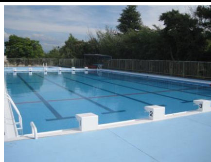
【プール改修工事が完了した真美ヶ丘東小学校プール】
