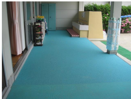
【廊下床修繕工事完了後の五位堂幼稚園】
