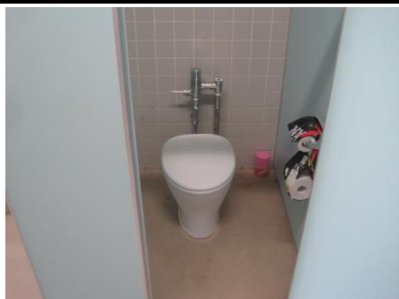
【トイレ洋式化工事が完了した志都美小学校屋外トイレ】
