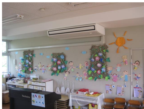
【認定こども園化改修工事完了後の鎌田幼稚園】
