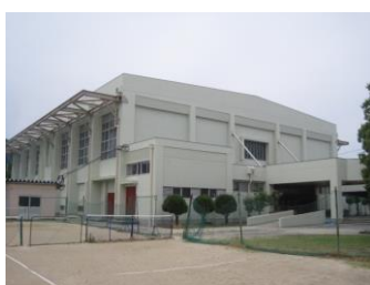
【大規模改造工事が完了した香芝中学校体育館】
