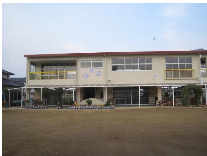
【耐震工事が完了した志都美幼稚園】
