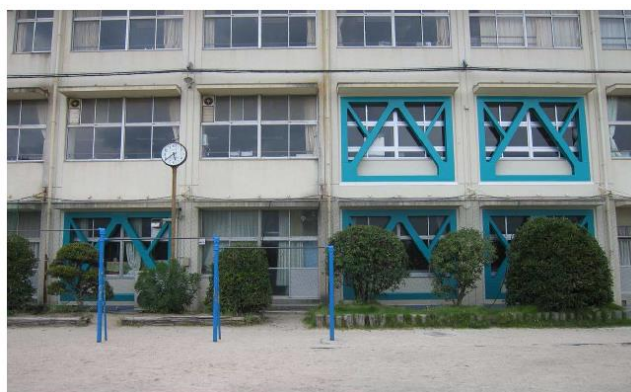
【耐震工事が完了した五位堂小学校】
