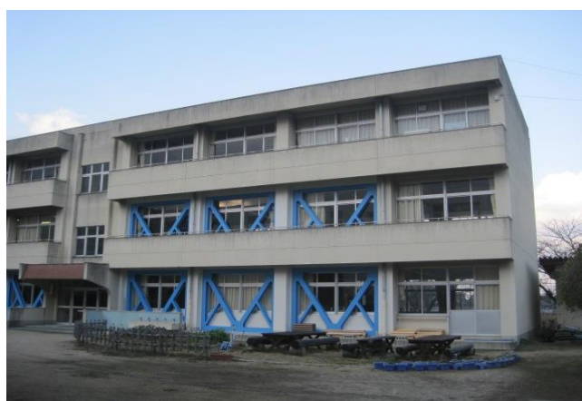
【耐震工事が完了した三和小学校】
