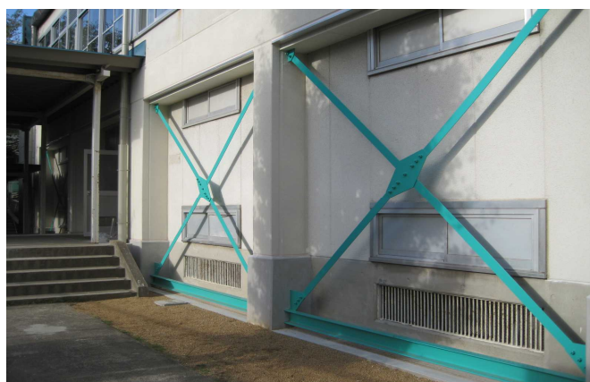
【耐震工事が完了した下田小学校体育館】
