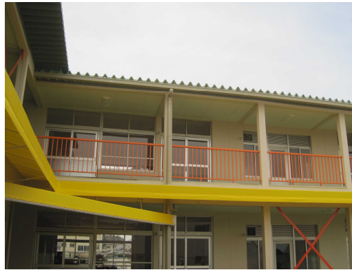
【耐震補強工事が完了した下田幼稚園】
