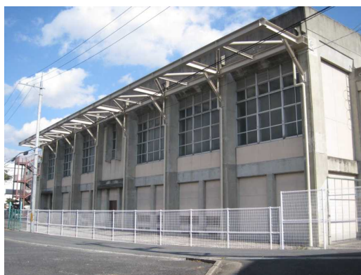
【耐震補強工事が完了した香芝中学校屋内運動場】
