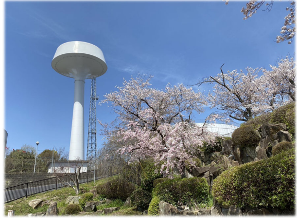
香芝市上下水道部・今泉配水場
